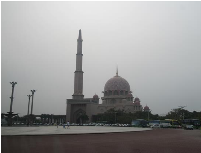
The Putra Mosque, Putrajaya.
