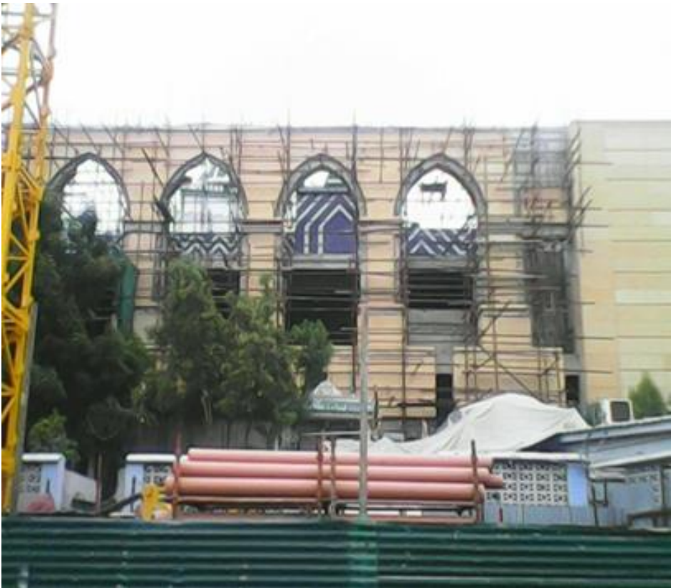
アブドゥッラー・シャー・ガズィー廟の改築工事の様子
