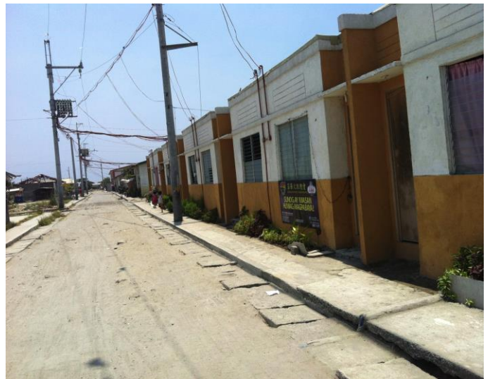
図 2：ナボタス市に建てられた再定住地
