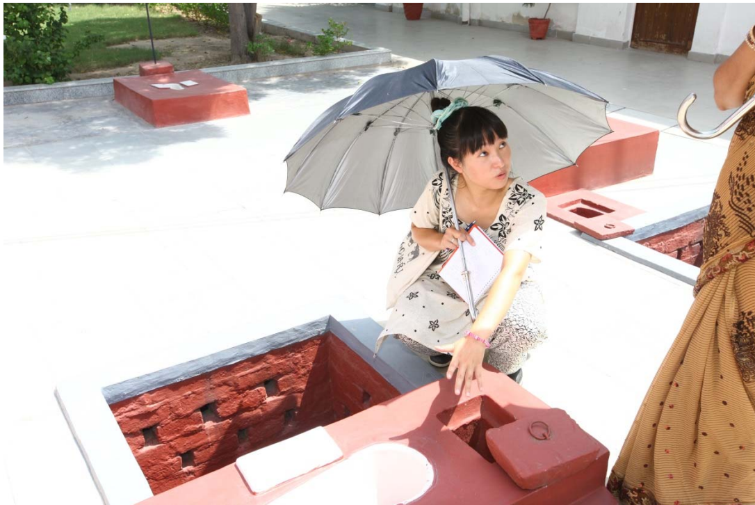
<写真 3 : Twin-pit Toilet の一種。材料は土>
