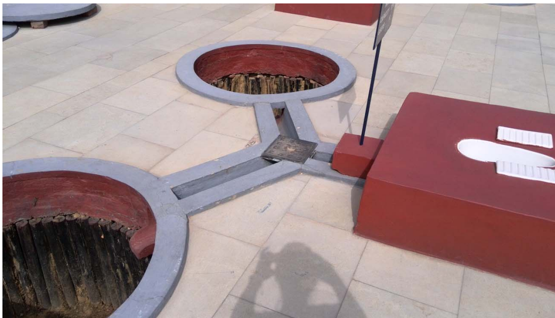
<写真2：Twin-pit Toilet の一種。材料は木材>
